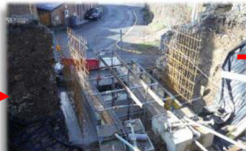
Mise en place des coffrages béton sous l'escalier et sur les côtés (dit mur de refend).
