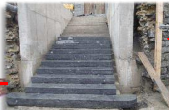
Repose des pierres retaillées, réparées et ponçées.
