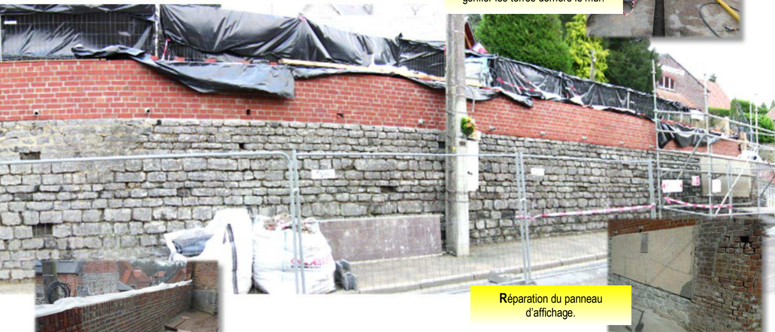
Pose d'un accodrain pour la collecte des eaux de pluie de la cour d'école. L'eau ne pourra plus gonfler les terres derrière le mur.
