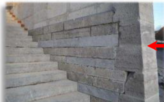
Ensuite même opération pour les pierres des flans. La pierre bleue ne supportera donc plus la pression des terres qui sont maintenant retenues par une solide paroi en béton armé, et cela pour de nombreuses années.
