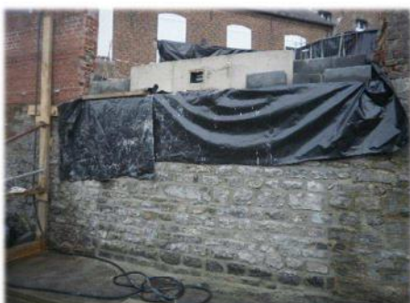
Après le coulage du béton de renfort, les vieilles pierres ont été replacées devant puis rejointoyées.
