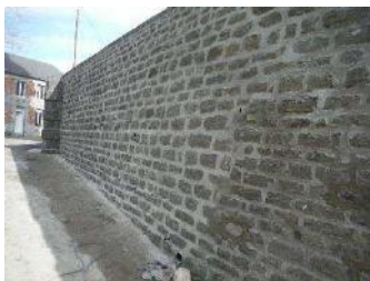
Rejointoiment des pierres vers l'ancien presbytère.
