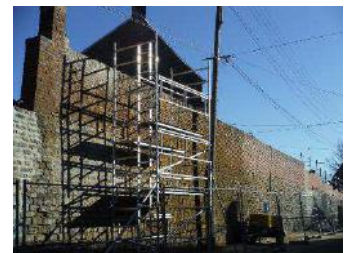
Jonction entre vieilles et nouvelles briques.
