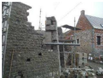
Jonction du mur aux pierres d'angles.
