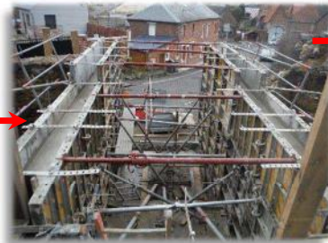
Mise en place des coffrages béton sous l'escalier et sur les côtés (dit mur de refend).
