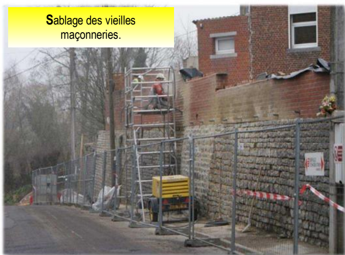
Jonction entre vieilles et nouvelles briques (côté cour).
