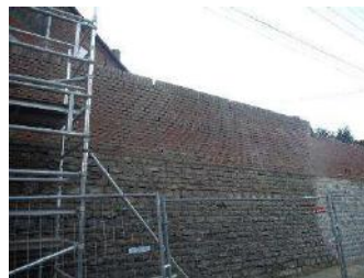
Sablage et rejointoiment des pierres et des briques.
